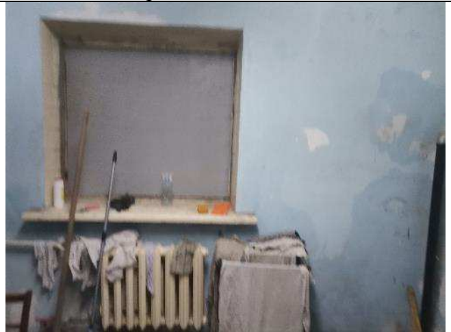
Фото 26. Места замачивания наружных стен в уровне подвала
