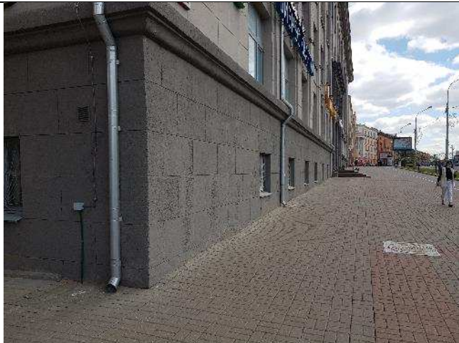
Фото 9. Отмостка из бетонной тротуарной плитки
