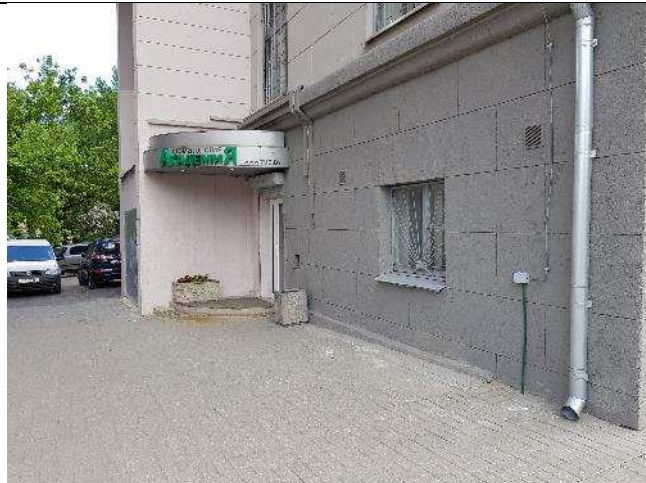
Фото 10. Отмостка из бетонной тротуарной плитки
