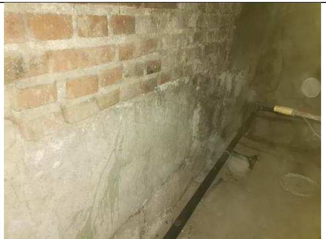
Фото 34. Места замачивания наружных стен в уровне подвала
