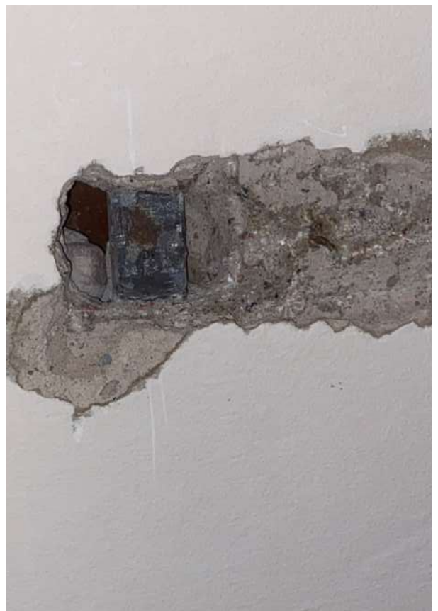
Фото 53. Общий вид вскрытия монолитной железобетонной плиты перекрытия в осях Б-В/2-3
