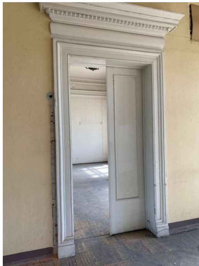
Фото 71. Общий вид деревянного дверного блока в осях Б-А/3
