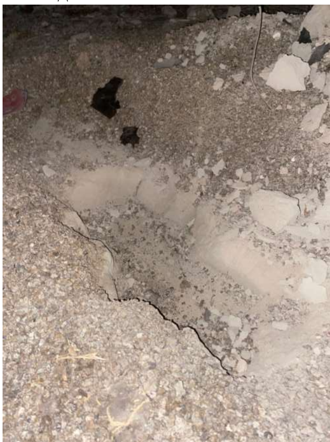
Фото 48. Общий вид вскрытия состава чердачного перекрытия
