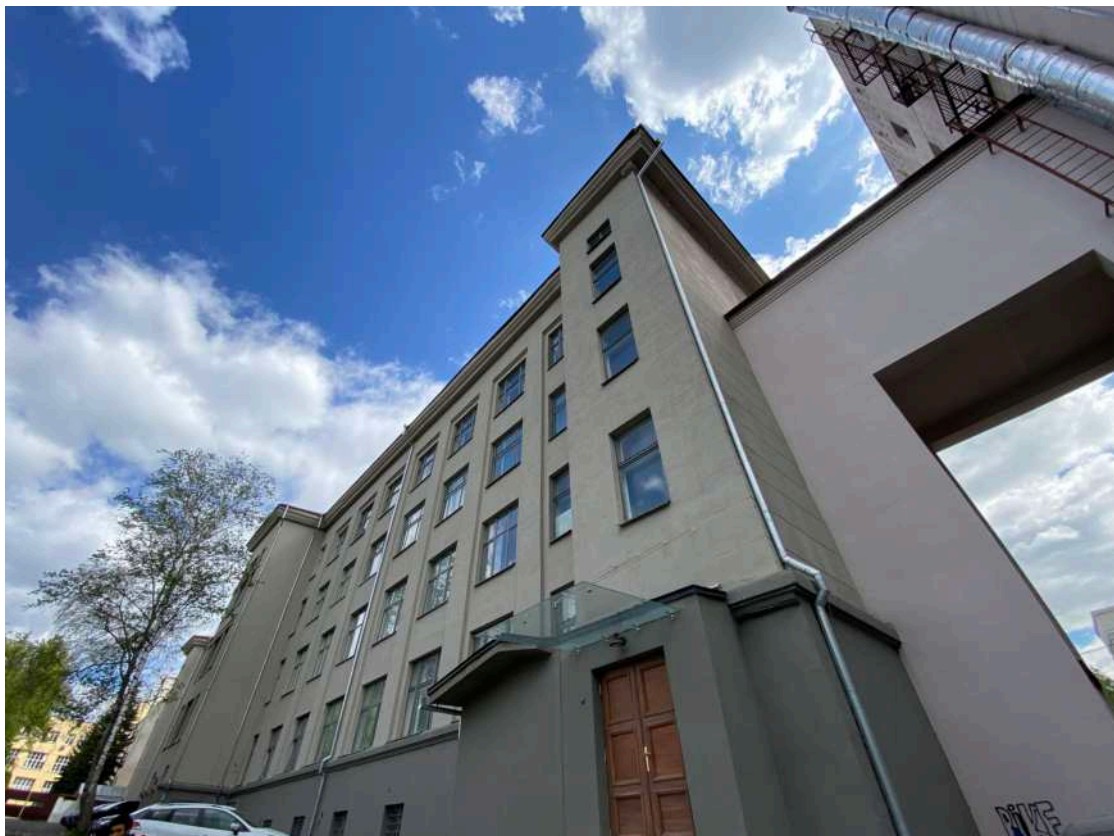
Фото 3. Фасад здания в осях Д-Г/4-1
