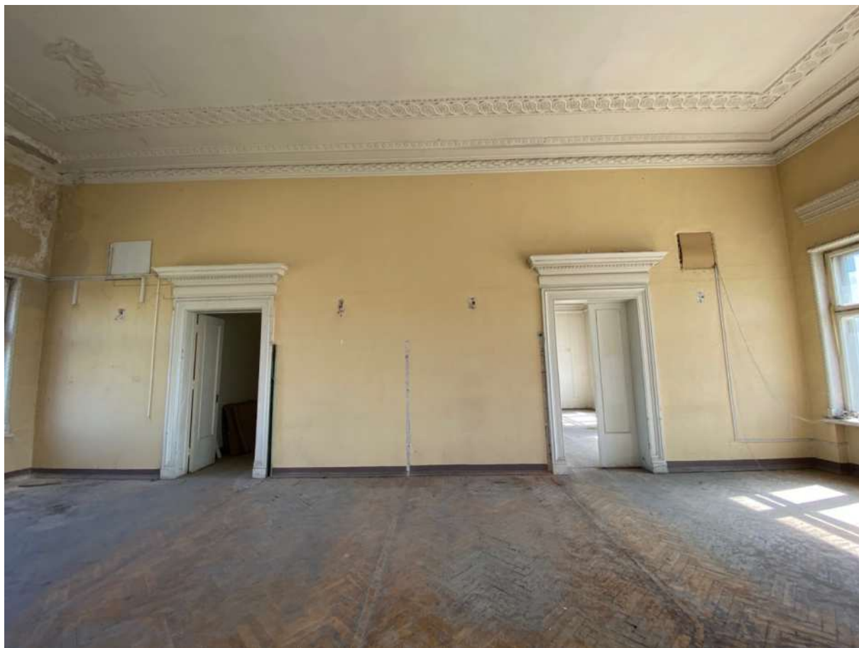
Фото 19. Общий вид внутренней стены в осях Г-А/3
