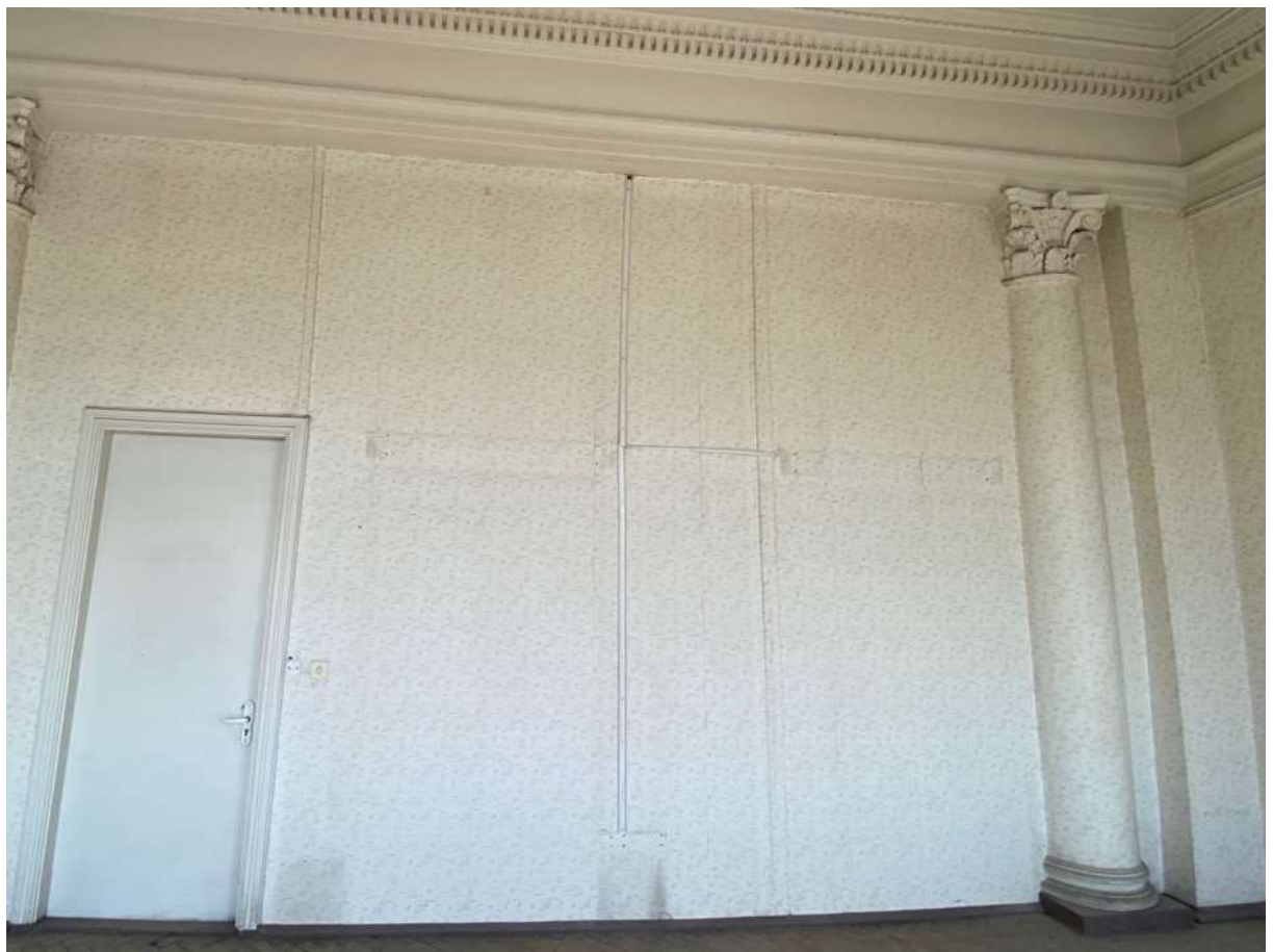
Фото 28. Общий вид перегородки в осях Б/3-4
