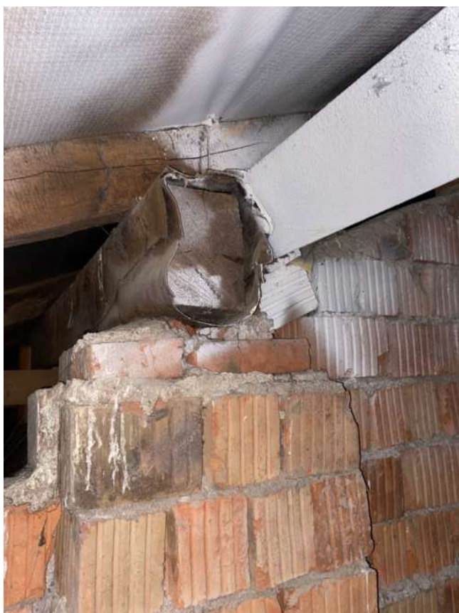
Фото 58. Общий вид узла опирания деревянного и металлического прогонов на кирпичную стену в осях Г-В/3
