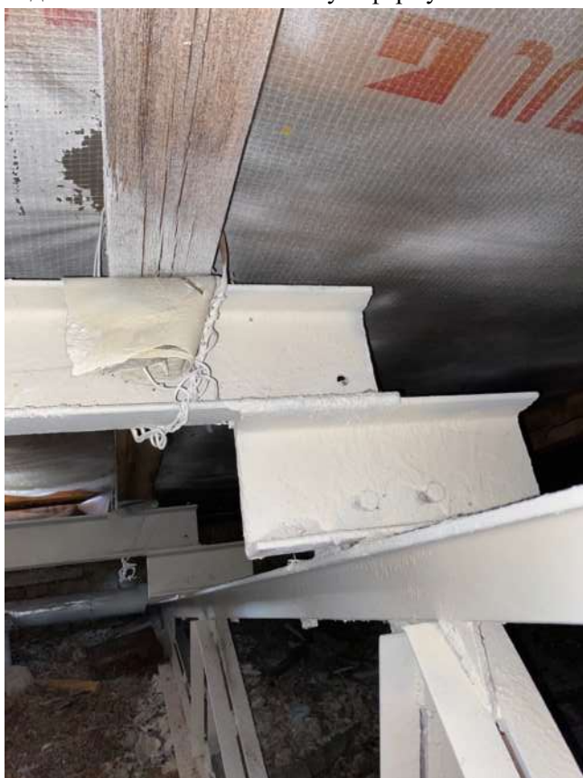
Фото 62. Общий вид узла опирания деревянной стропильной ноги на металлический прогон
