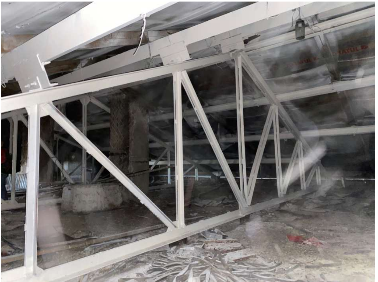
Фото 54. Общий вид металлической фермы в осях А-Г/2-3
