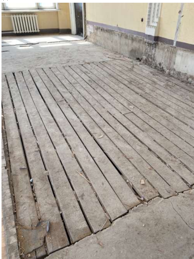
Фото 84. Общий вид дощатого и бетонного основания пола под паркетную доску в осях Б-В/2-3
