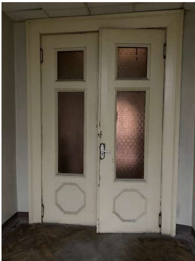
Фото 68. Общий вид деревянного дверного блока в осях Б-В/4
