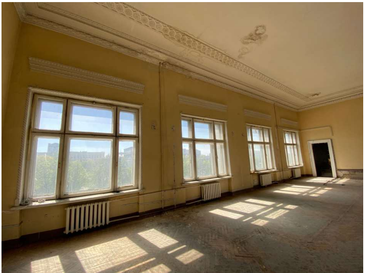
Фото 8. Общий вид наружной стены в осях А/3-2
