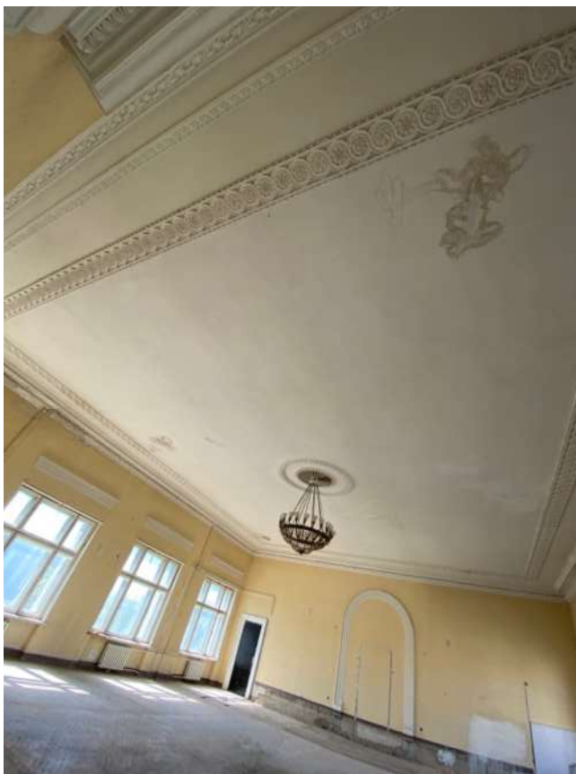
Фото 38. Общий вид отделочного слоя чердачного перекрытия в осях А-Г/2-3
