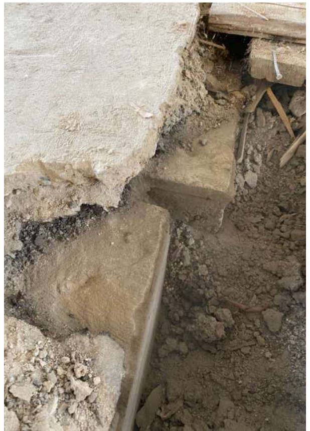
Фото 51. Общий вид железобетонных плит перекрытия в уровне пола 4 этажа
