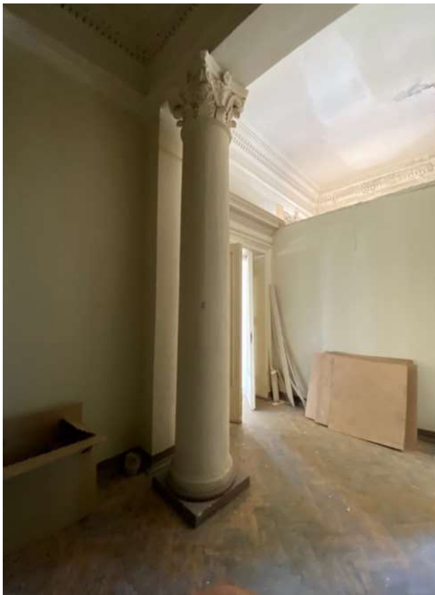
Фото 34. Общий вид железобетонной колонны в осях В/3
