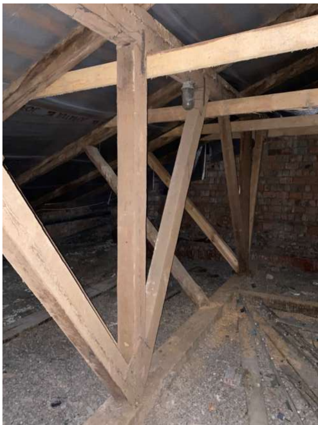
Фото 56. Общий вид деревянной стропильной системы в осях А-Б/3-4
