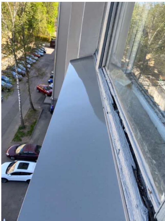
Фото 76. Общий вид оконного отлива в осях Г/2-3
