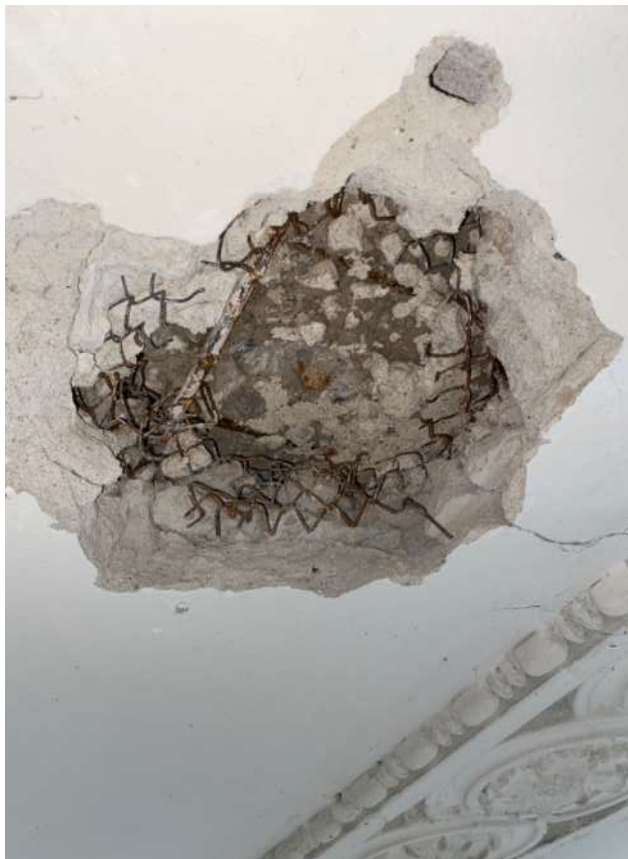
Фото 50. Общий вид вскрытия отделочного слоя (толщиной t=90\text{мм} ) чердачного перекрытия в осях Г/2
