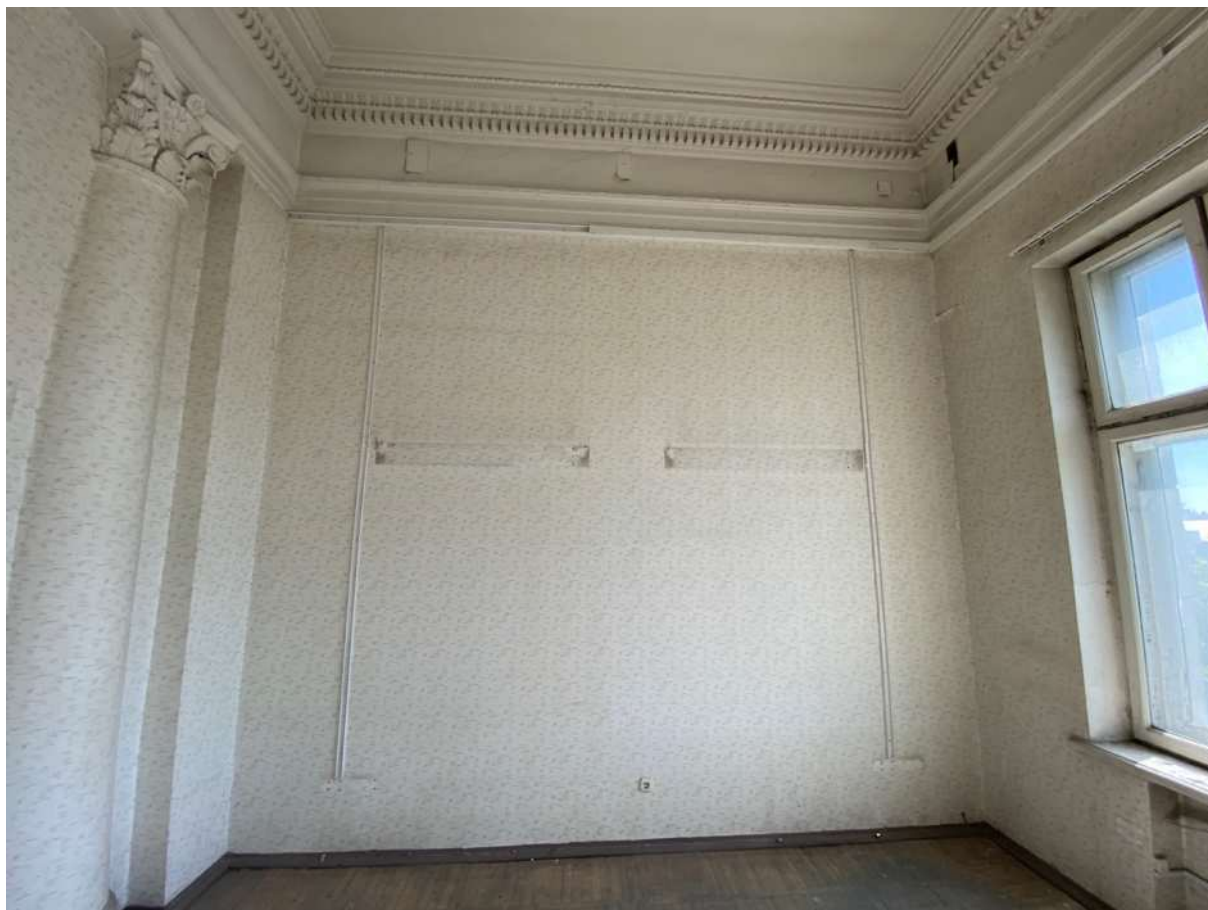
Фото 21. Общий вид внутренней стены в осях Б-А/4
