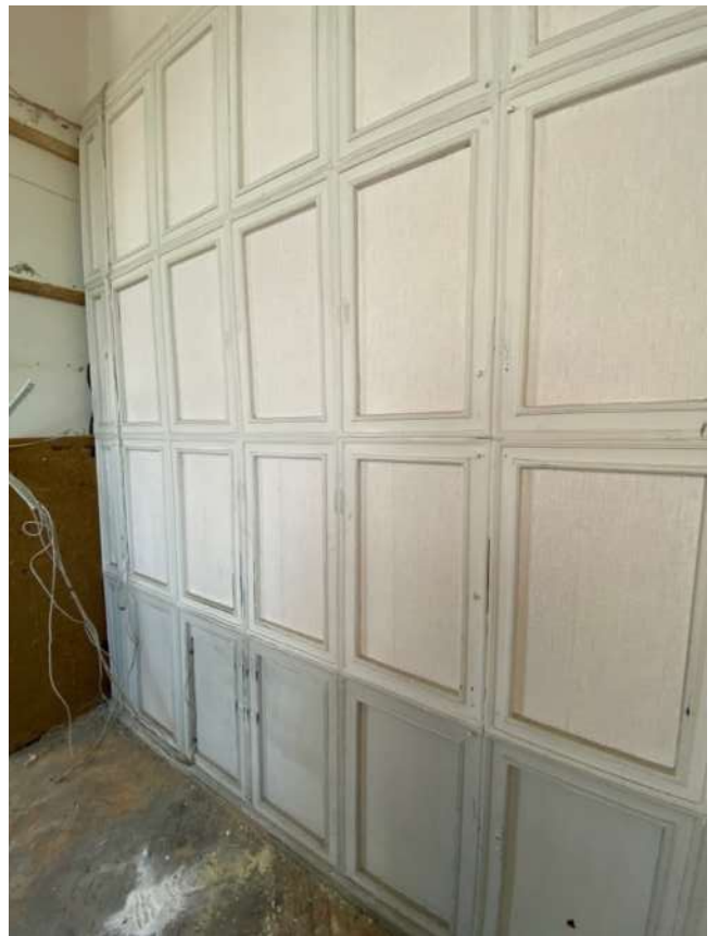
Фото 32. Общий вид обшивки перегородки декоративными деревянными панелями в осях Б-А/2
