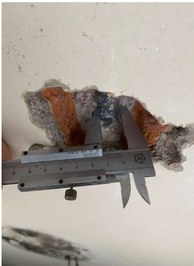
Фото 52. Общий вид вскрытия сплошной железобетонной плиты перекрытия в осях В-Г/2-3
