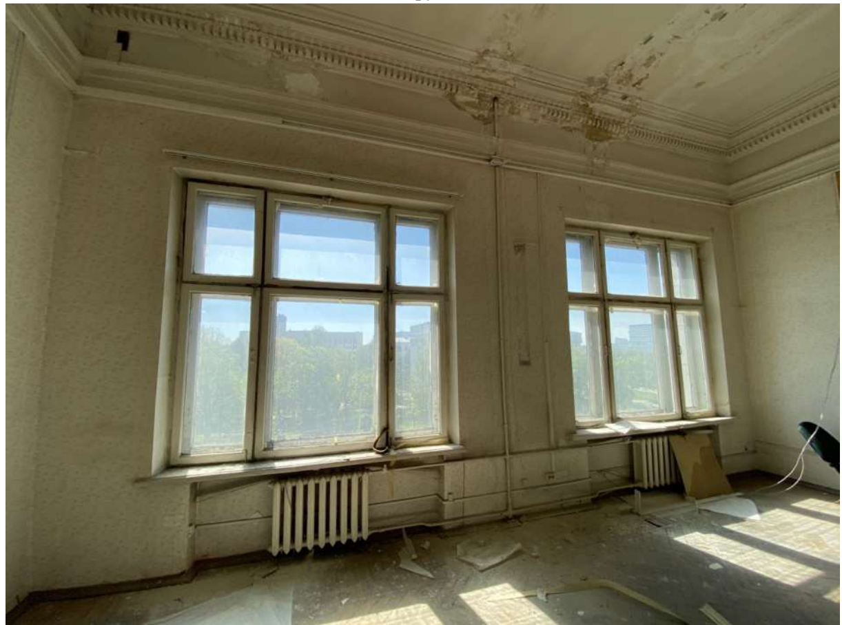
Фото 9. Общий вид наружной стены в осях А/4-3
