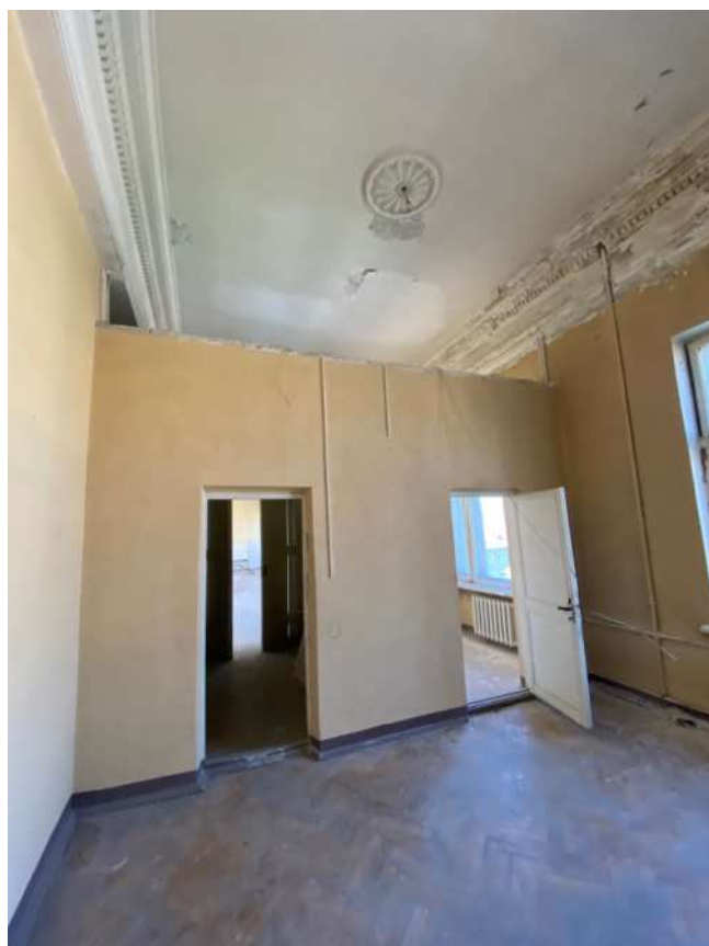
Фото 27. Общий вид перегородки в осях В-Г/3-4
