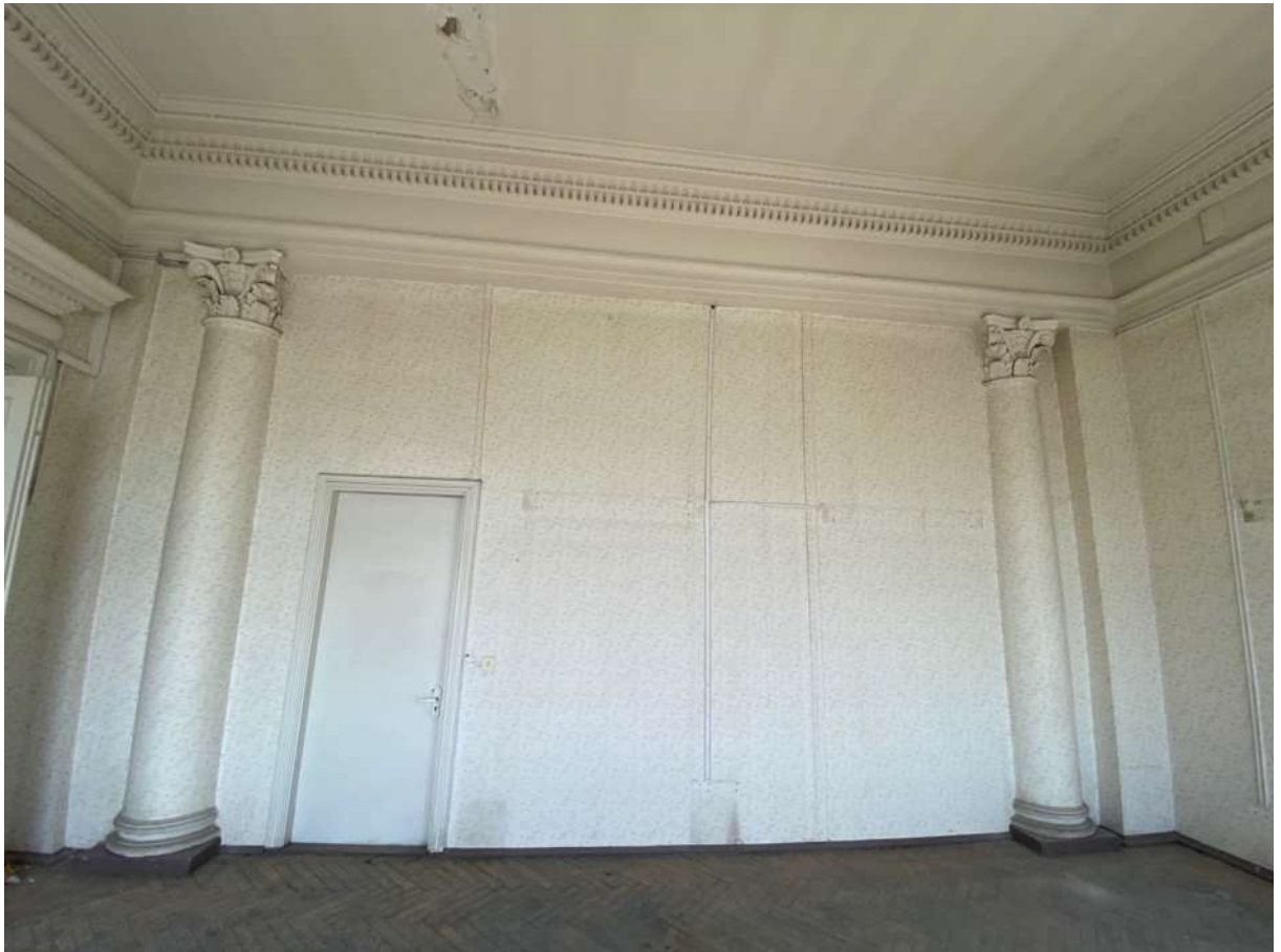
Фото 33. Общий вид конструкций каркаса в осях Б/3-4
