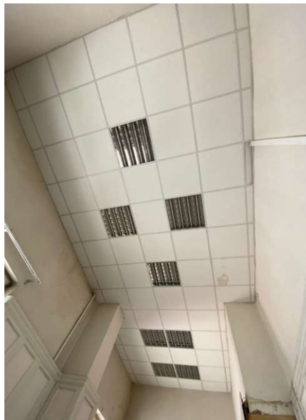
Фото 45. Общий вид подвесного потолка типа «Армстронг» в осях А-В/1-2
