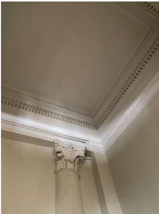
Фото 36. Общий вид отделочного слоя чердачного перекрытия в осях Б-В/3-4
