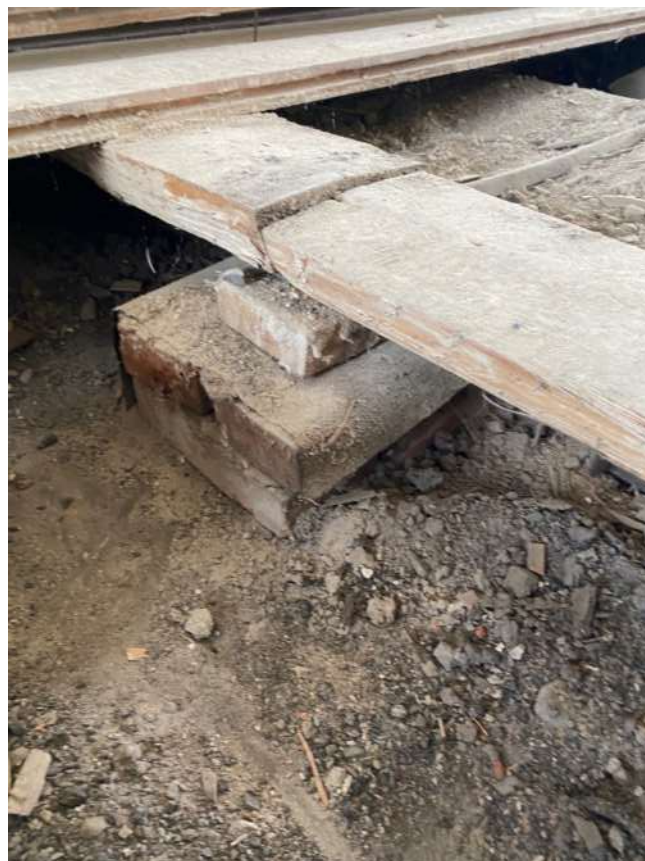
Фото 87. Общий вид состава пола в осях Б-В/2-3
