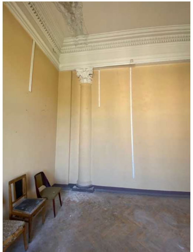
Фото 35. Общий вид железобетонной колонны в осях В/4-3
