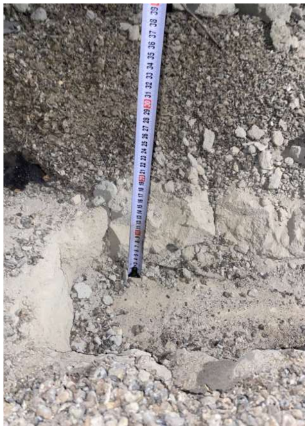
Фото 47. Общий вид вскрытия состава чердачного перекрытия
