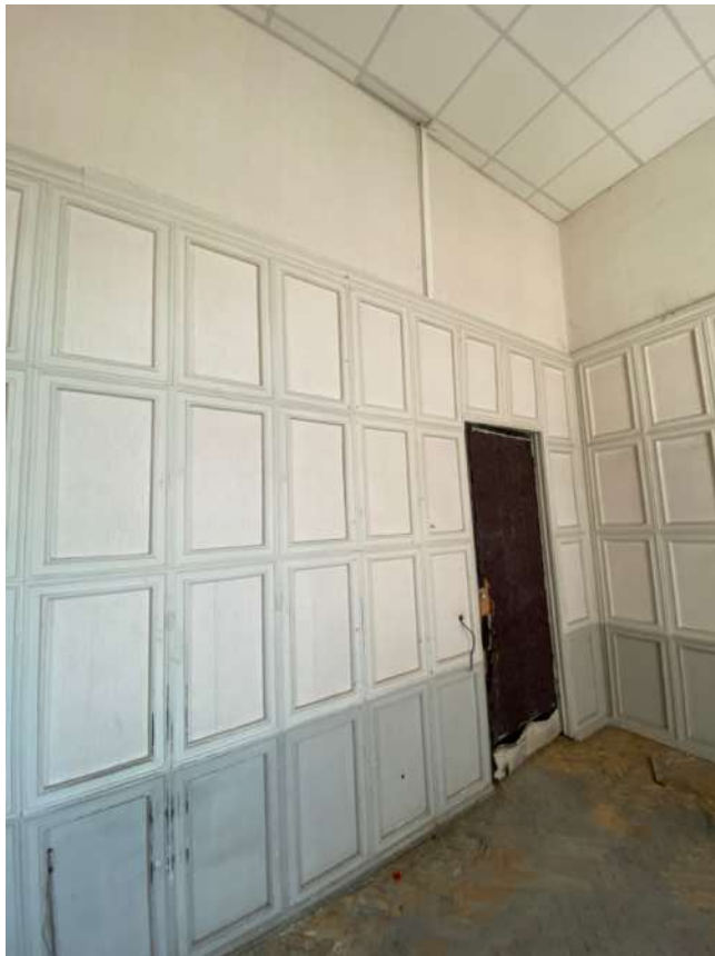
Фото 29. Общий вид перегородки в осях Б-А/2
