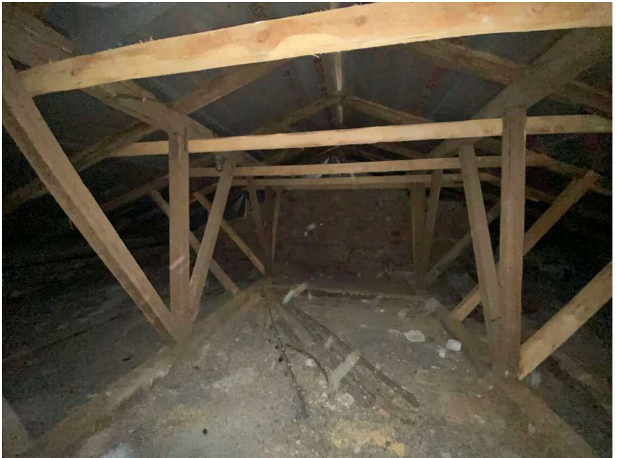
Фото 55. Общий вид деревянной стропильной системы в осях А-Г/3-4
