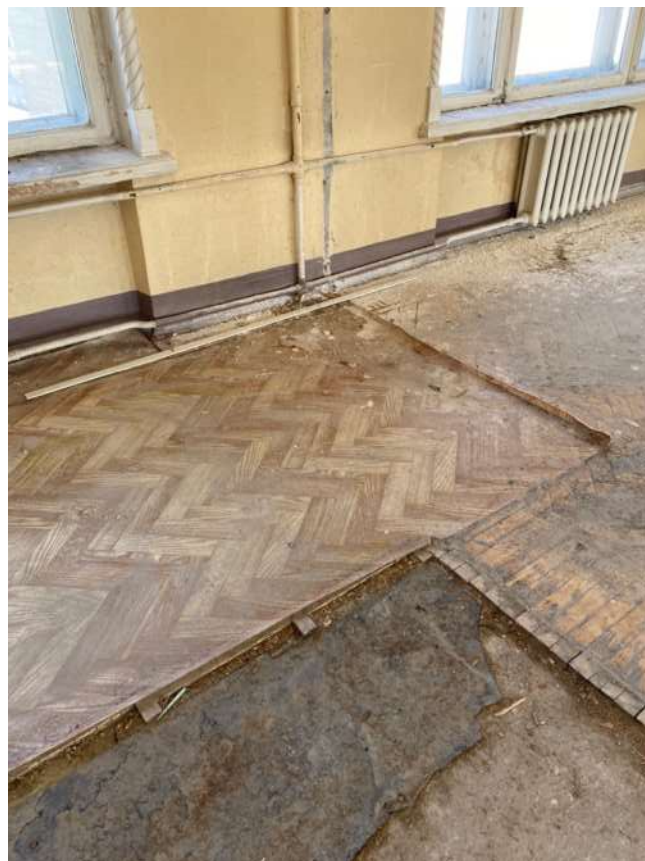
Фото 83. Общий вид покрытия участка пола из линолеума в осях Г/2
