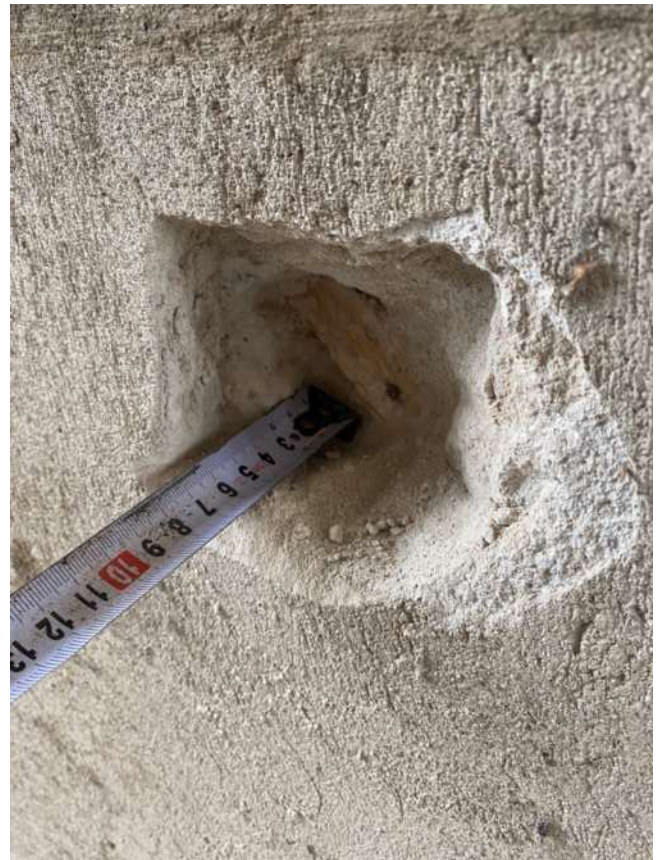
Фото 30. Общий вид вскрытия отделочного слоя деревянной перегородки в осях А-Б/2
