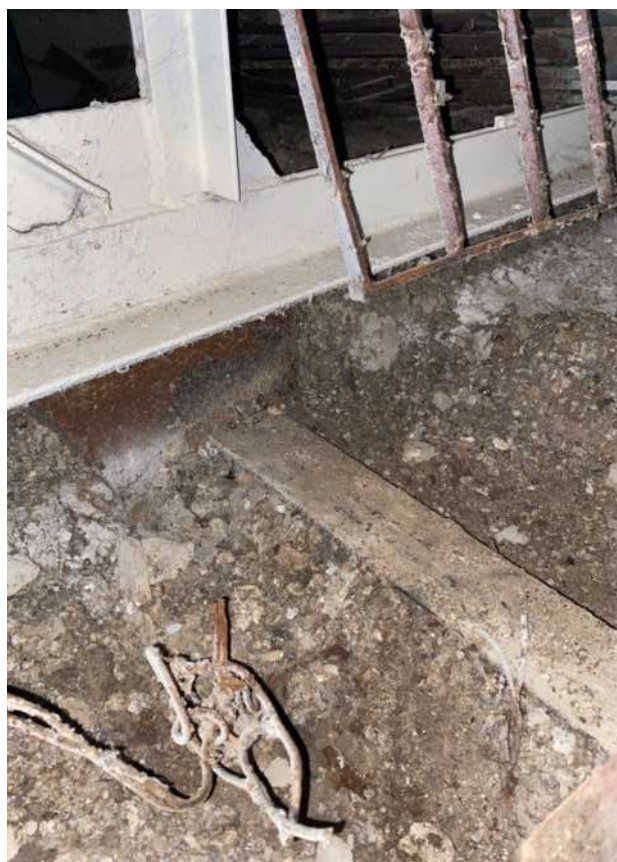
Фото 49. Общий вид узла крепления двутавровой балки чердачного перекрытия к нижнему поясу металлической фермы
